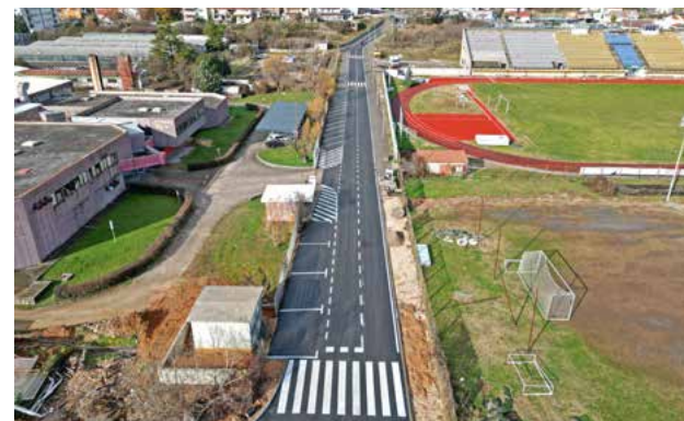
Obnovljena prometnica, Bare – Čitluk
